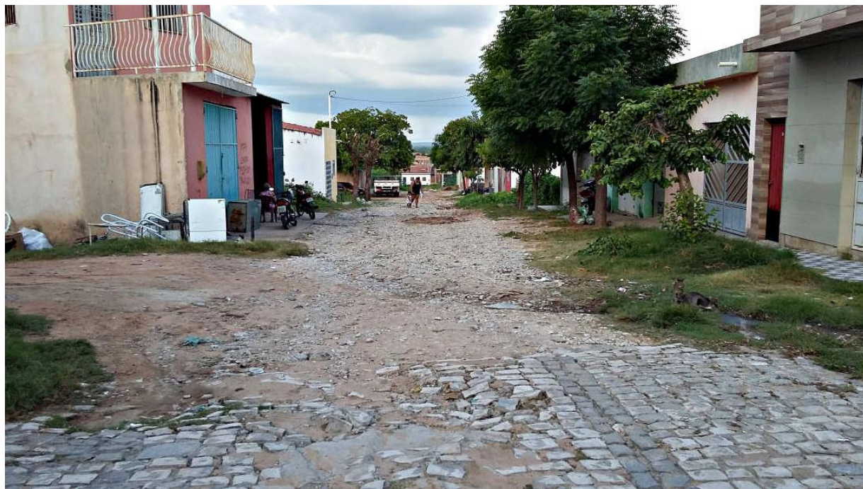
RUA ADEMAR LEÃO DA SILVEIRA (Ponto de Visão: Sentido Oeste-Leste)
