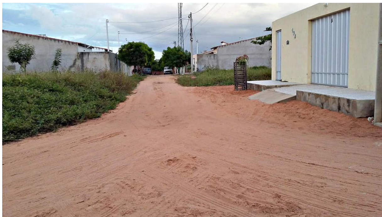
RUA MÁRIO ALBUQUERQUE DE FREITAS (Ponto de Visão: Sentido Oeste-Leste)
