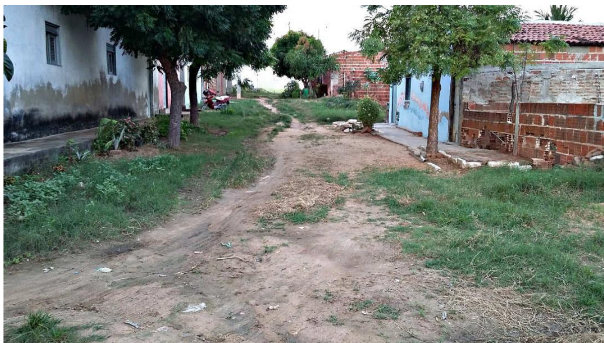
RUA SÃO JOSÉ (Ponto de Visão: Sentido Oeste-Leste)
